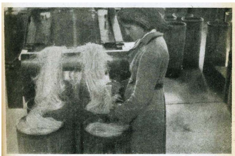
Estirado del manajo o manto de fibra en la máquina preparadora o carda. La materia prima se manipula en los botes de madera terciada que se ven al frente. La Banda (Santiago del Estero)
